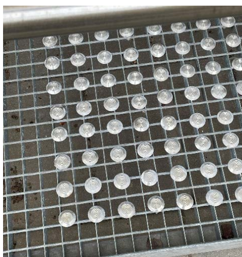
7 pav. Taktilinių paviršių tvirtinimas prie plieninių grotelių
